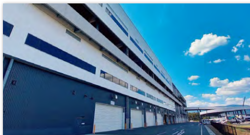
九州物流センター / 福岡県小郡市
