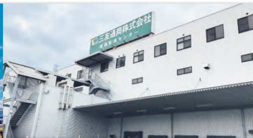
福岡物流センター / 福岡県福岡市博多区
